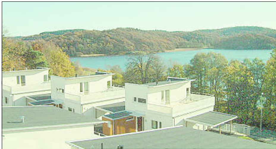
NCC Boende har uppfört Stensjöberg i byggkrävande bergslutning till utsatt tid, med nöjda kunder.
