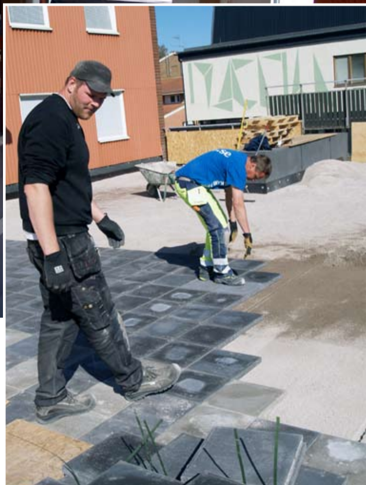
Nylagda terrasser på Centrumgatan, kvarteret Hunden. Lägenheternas terrasser har i år fått nya tätskikt och mönsterlagda plattor.
