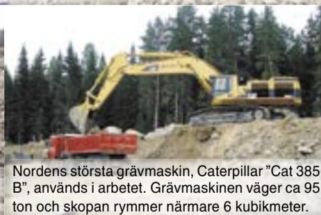
Nordens största grävmaskin, Caterpillar "Cat 385 B", används i arbetet. Grävmaskinen väger ca 95 ton och skopan rymmer närmare 6 kubikmeter.
