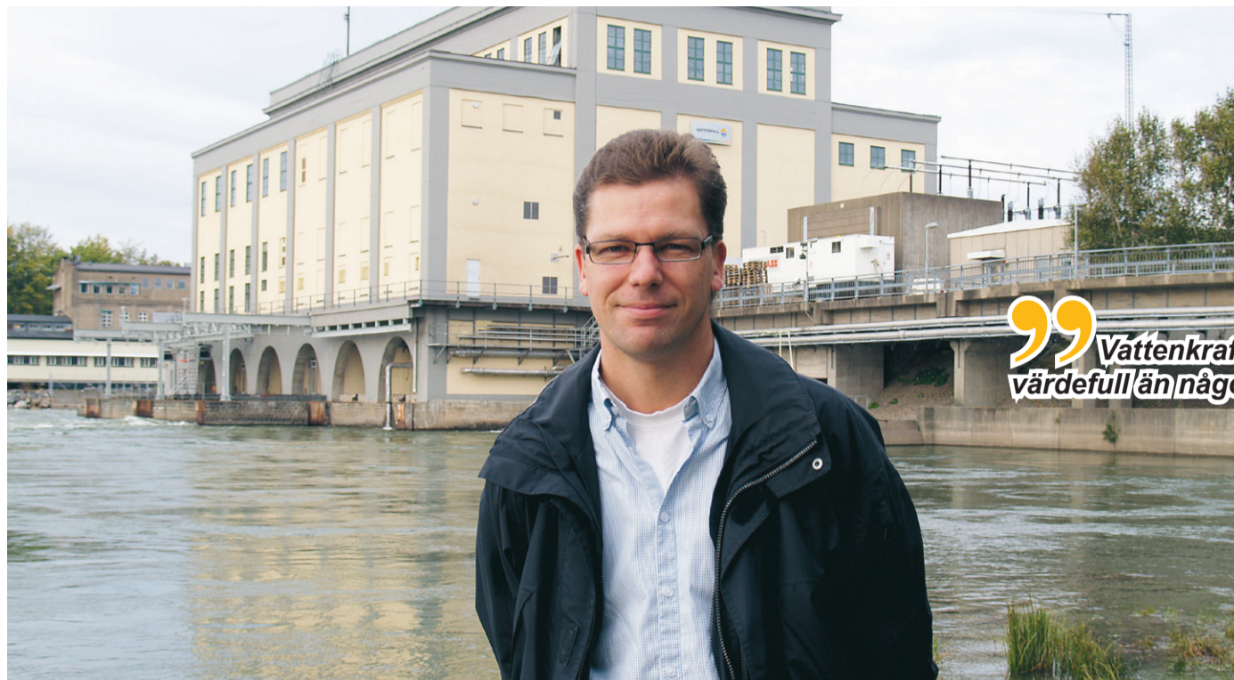
Vattenkraftverket i Lilla Edet är ett landmärke sedan 1926. Nu investerar Vattenfall mångmiljonbelopp i kraftverket. På bilden Magnus Carlson, Vattenfalls områdesansvarig för Göta Älv.
