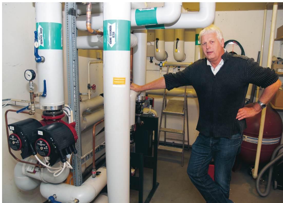
Fjärrvärmeinstallation i bostadsrättsföreningen Lustgårdens källare är liten, ren och tyst. Ordförande Ingvar Ekelund är mycket nöjd med fjärrvärmesystemet.
