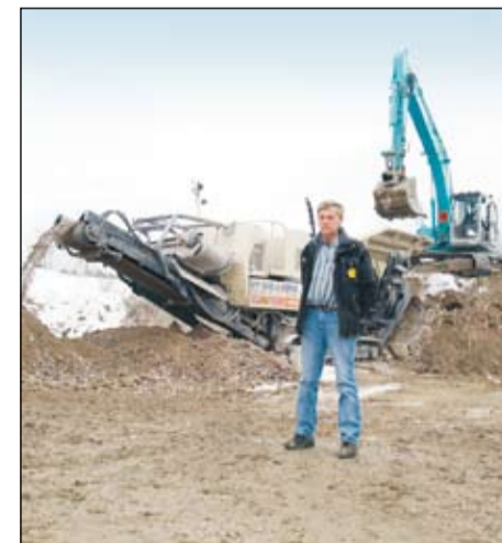
Grus & Byggåtervinning alltid på plats. Verksamhetsansvarige Ove Ahlén framför en av företagets grävmaskiner och krossverk.
